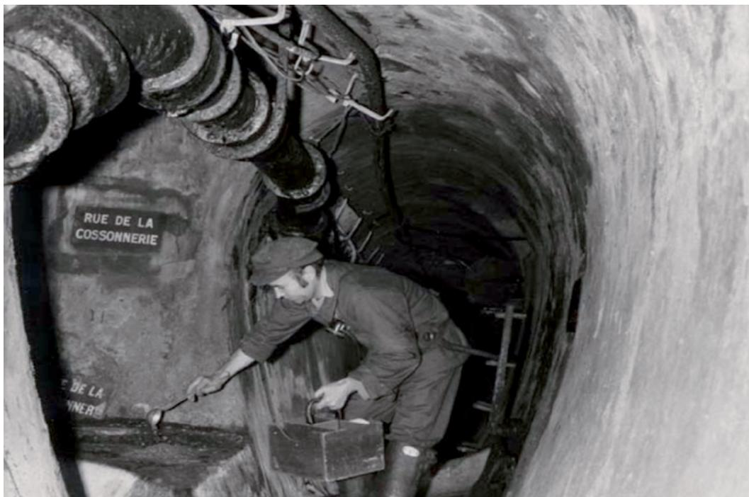
**Fig.1: operaio addetto alla manutenzione dei condotti fognari. Si può notare dalla targa sulla sinistra della foto la rispondenza con la rete viaria sovrastante.**
